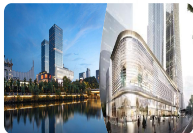
杭州中心四季酒店 青岛GT Plaza 顺利开业
